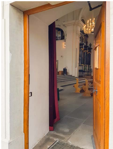
Die erste Türe auf der Turmseite wird automatisiert.
