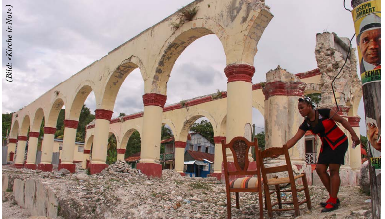
Bereits beim Erdbeben im Jahr 2010 wurden Kirchen auf Haiti zerstört.
