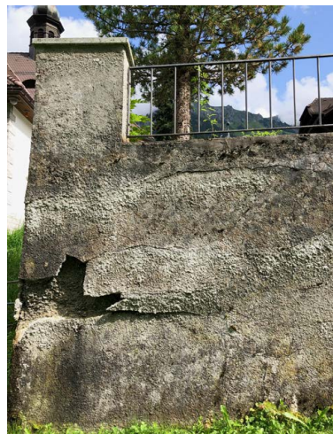
Der aktuelle Zustand der Friedhofsmauer.
